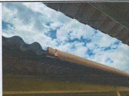
Foto1: Sustitucion e instalacion de canal Aluzinc calibre 26, esta quebrado en direccion y aula 1
