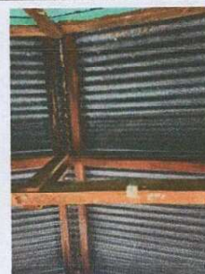
Foto 2: Sustitucion de estructura y cubierta de lamina por estructura metalica galvanizada, cargadores de 4"x4" y costanera de 4"x2" en aula 4
